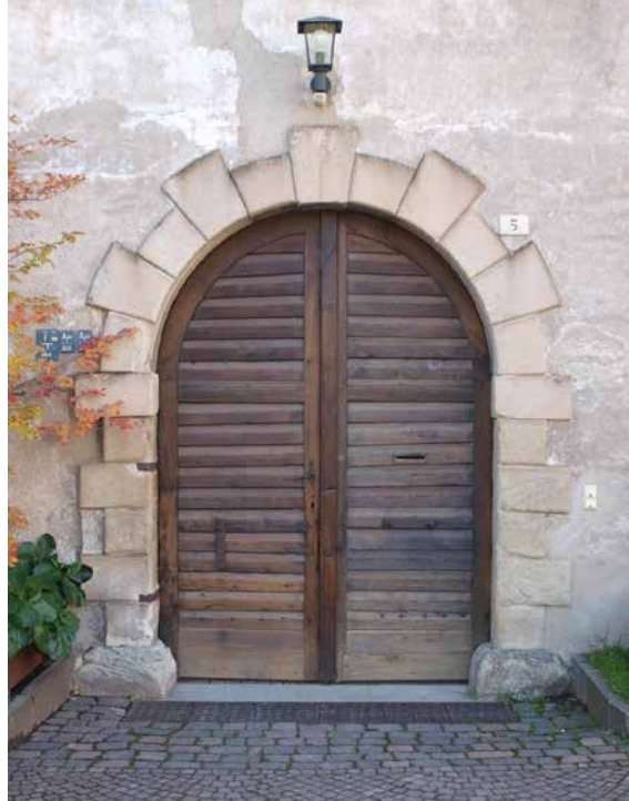
Mariaheim, Nordportal Mariaheim, portale a nord
