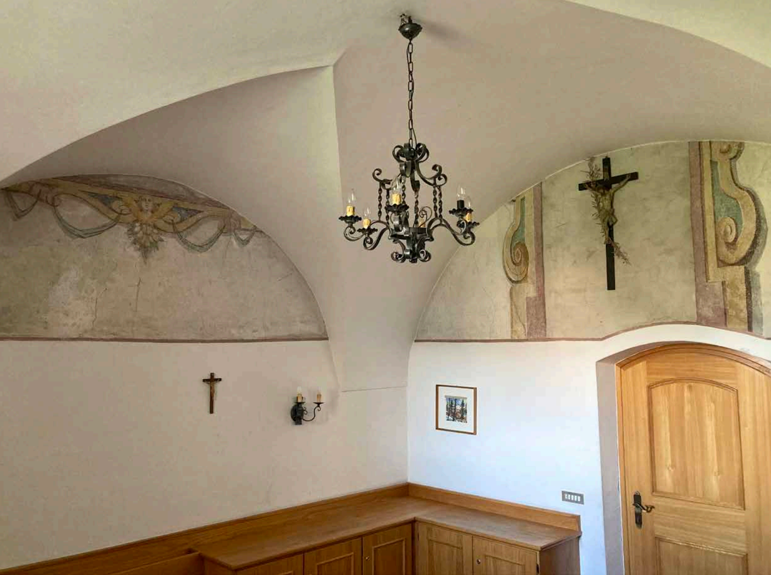
Raum mit Wandmalerei-Fragmenten von ca. 1640 im Erdgeschoss des Westtrakts
