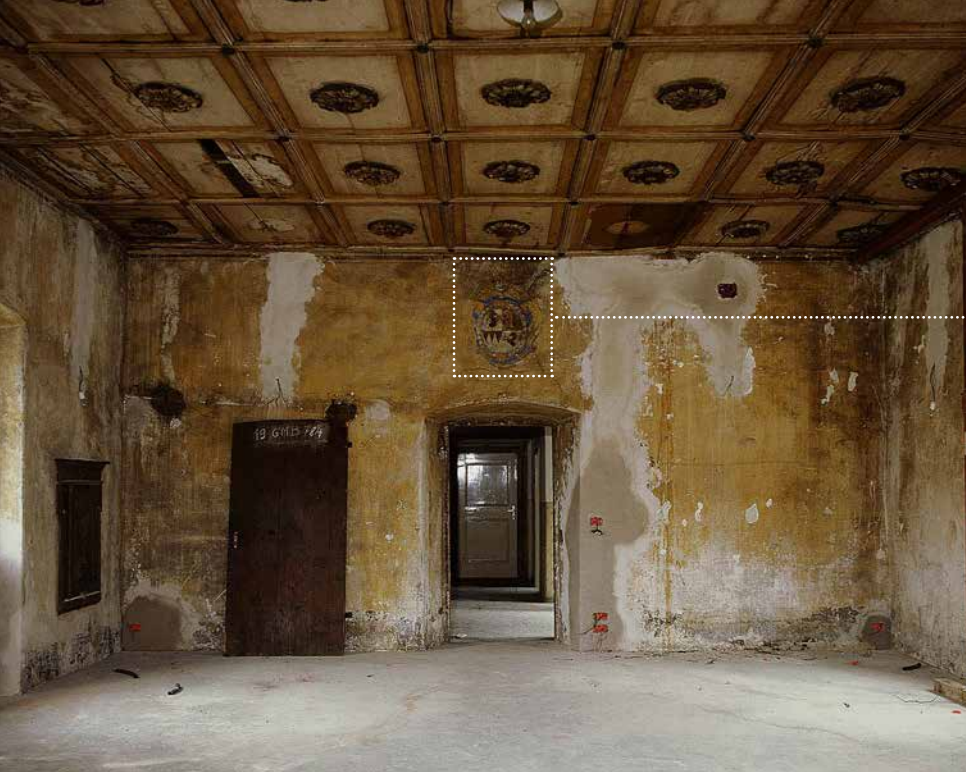
Der „Kassettensaal“ vor der Restaurierung La “sala a cassettoni” prima del restauro
