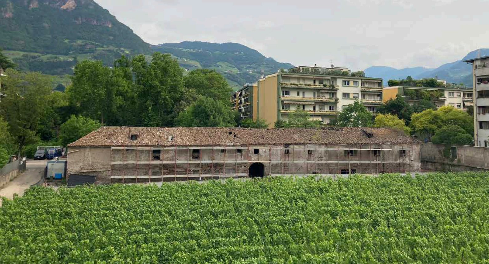
Das ehemalige Stall- und Stadelgebäude während der Sanierung 2022
