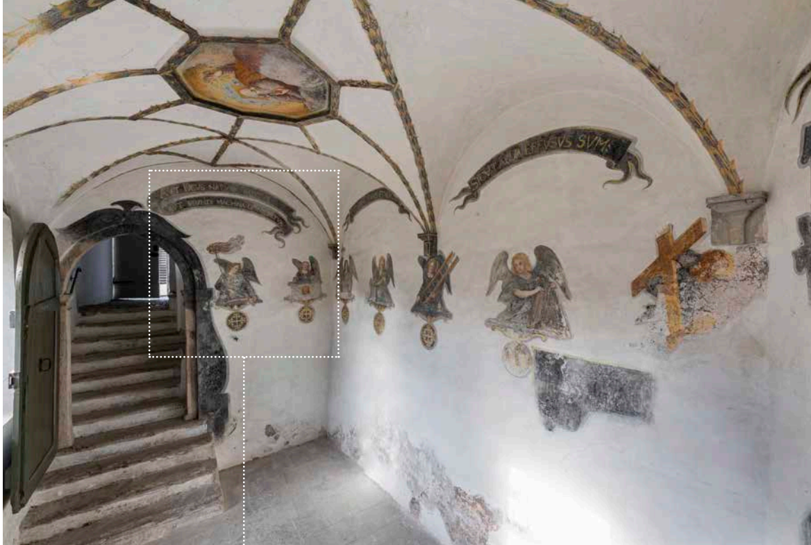
Gruftkapelle, Blick zur Eingangs- und Nordwand
