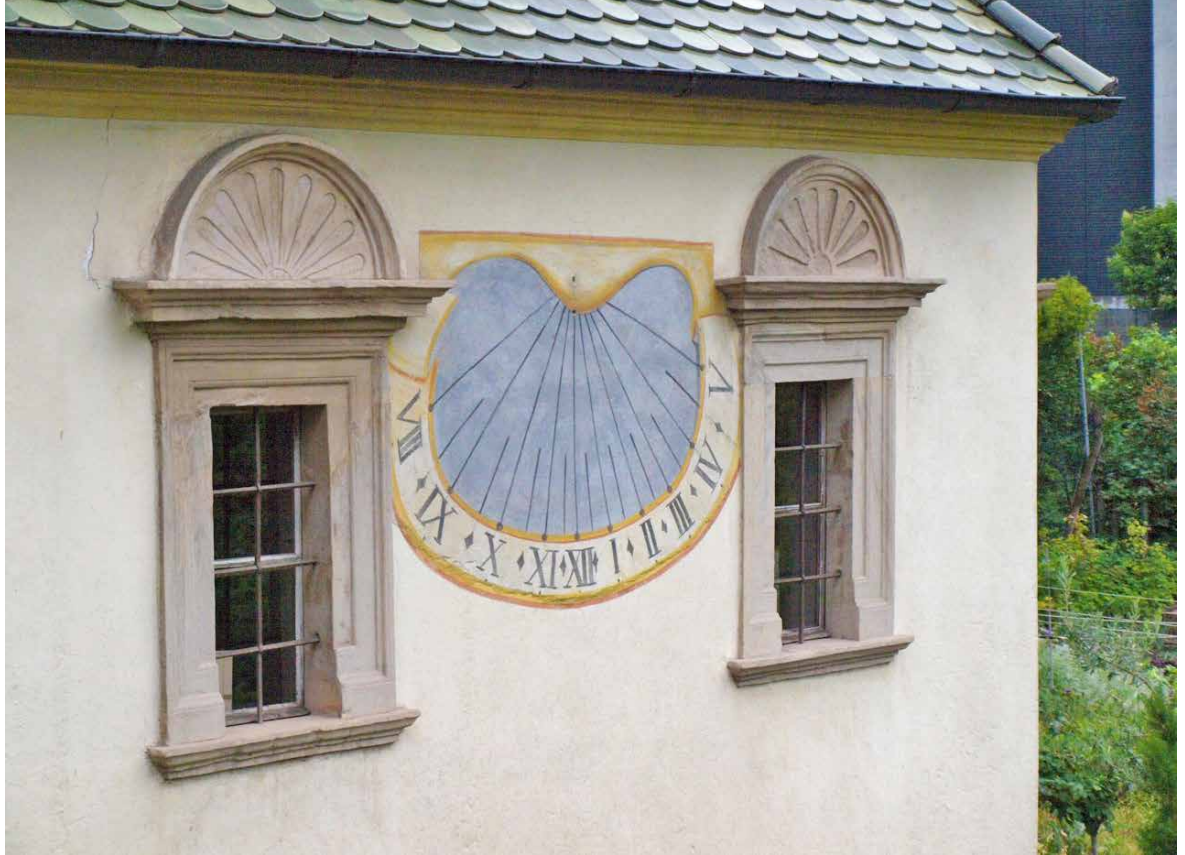
Südfassade der Augustinuskapelle mit Sonnenuhr
