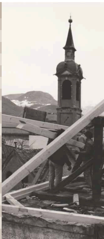
Sanierung des Südtrakts im März 1987
